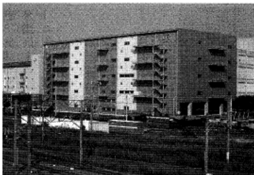
エフ・プラザ東京新C棟
